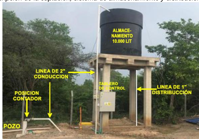
Imagen 5. Descripción de la captación, sistema de almacenamiento y distribución del agua captada
