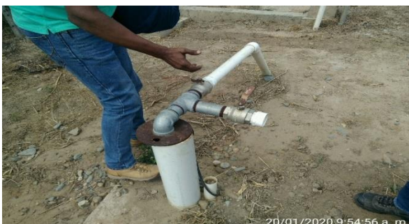
Fotografía 2. Estado actual del pozo
