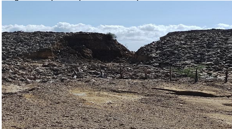
Fotografía 5. dique de represamiento roto por donde se vació el embalse
