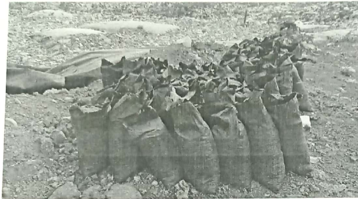
Foto 8. Fecha 11 de diciembre de 2018. Material de excavación dispuesto para reparación las burbujas de aire en la celda.
