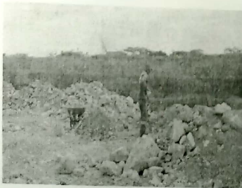
Fotos No 20 y 21. Fecha 11 de diciembre de 2018. Aprovechamiento de escombros para arreglo de vías internas.
