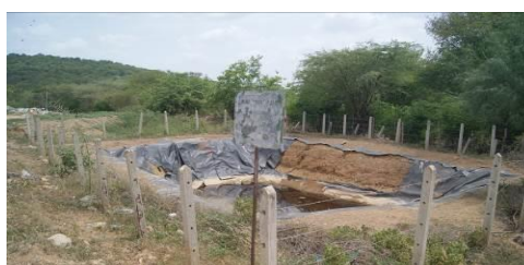
Foto No 25 y 26. Laguna de lixiviado No 4 con lixiviados pero deteriorada.
