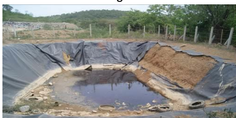
Foto No 25 y 26. Laguna de lixiviado No 4 con lixiviados pero deteriorada.
