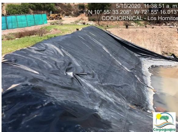
Fotografía No. 25 y 26. Relavera construida para la recolección de las aguas residuales no domesticas provenientes de la empresa Sira Minerales S.A.S. CENTRO MINERO COOHORNICAL. (Fuente: Corpoguajira 2020).
