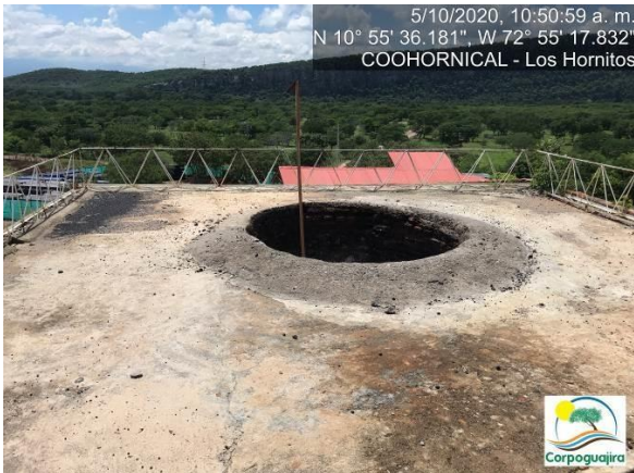
Fotografía No. 11 y 12. Hornos incineradores construidos en las instalaciones del centro minero. CENTRO MINERO COOHORNICAL. (Fuente: Corpoguajira 2020).
