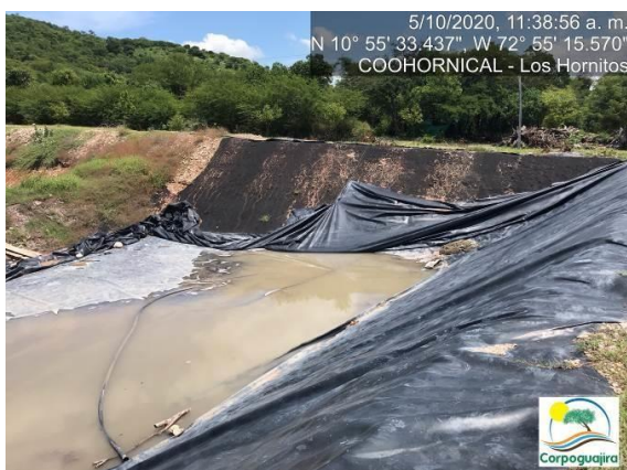
Fotografía No. 27 y 28. Relavera construida para la recolección de las aguas residuales no domesticas provenientes de la empresa Sira Minerales S.A.S. CENTRO MINERO COOHORNICAL. (Fuente: Corpoguajira 2020).
