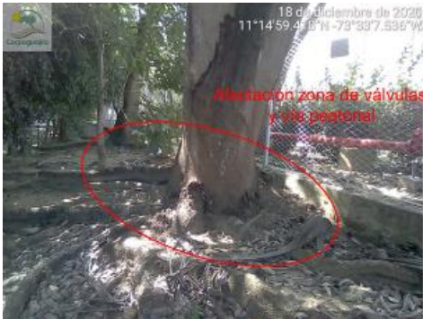
Fotografía 2 Afectación radicular en el área de válvulas
