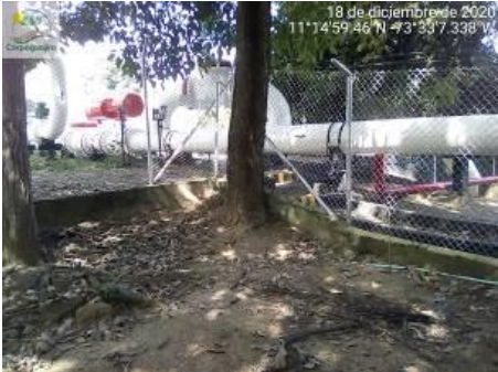
Fotografía 4 Sistema radicular descubierto e interferencia con la malla perimetral
