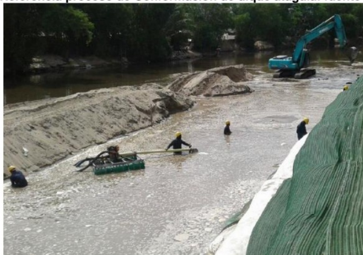
Imagen 13. Referencia proceso de Conformación de dique ataguía: fuente el solicitante
