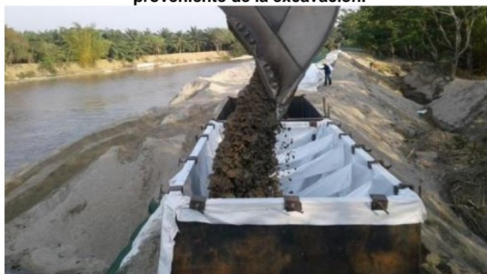
Imagen 14. Proceso de llenado de geocontenedor dentro de la formaleta metálica con material proveniente de la excavación.
