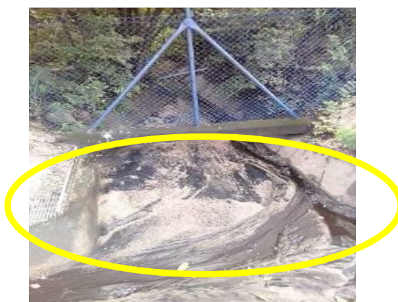
Figura 23. Rastros de carbón en el canal que recoge las aguas que salen del patio de carbón y que comunica a un cuerpo de agua.
