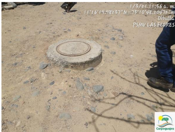
Fotografías No 7. Manjol del sistema de alcantarillado instalado en el corregimiento de Las Flores. 1 de marzo del 2021 (fuente CORPOGUAJIRA)
