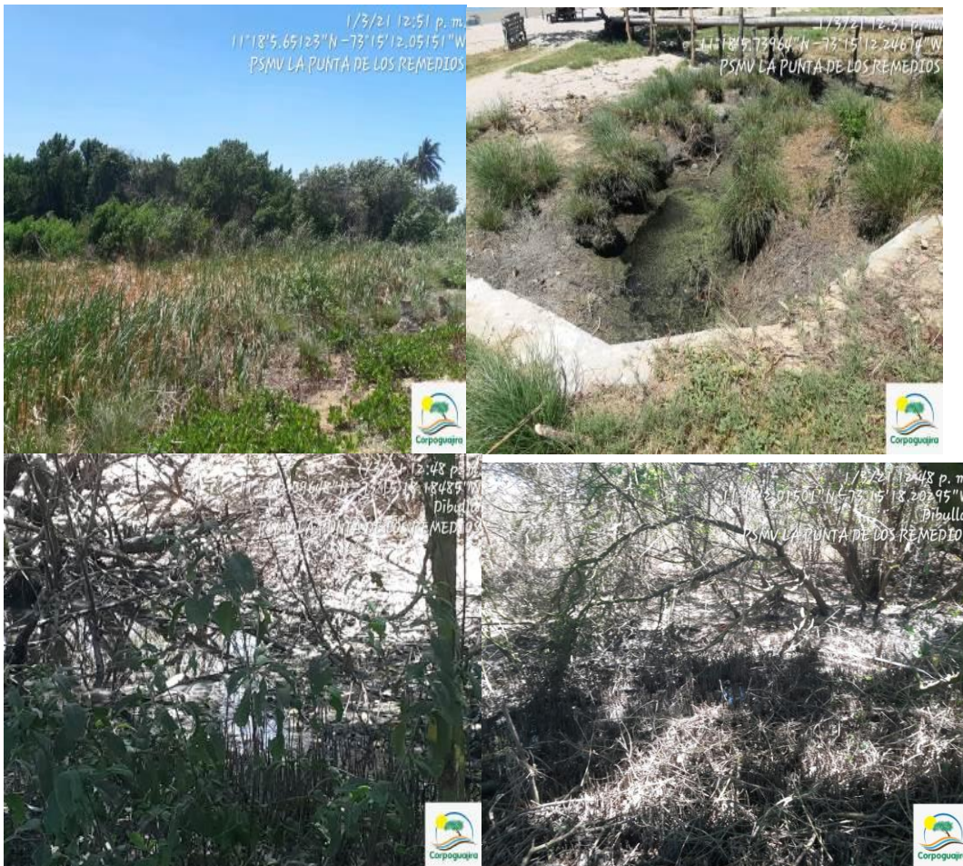
Fotografías No 1 – 4. Zonas donde se presenta rebose de agua residual doméstica, inundación y olores ofensivos.
