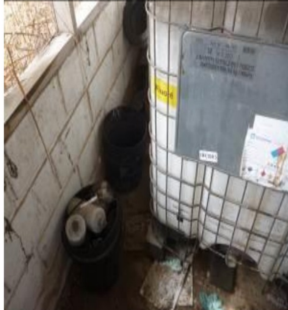
Fotografías 9, 10, 11, 12. Área destinada al almacenamiento de residuos o desechos peligrosos, vestigios de derrames de hidrocarburo, techos partidos que permiten el ingreso de humedad. 8 de abril de 2016.
