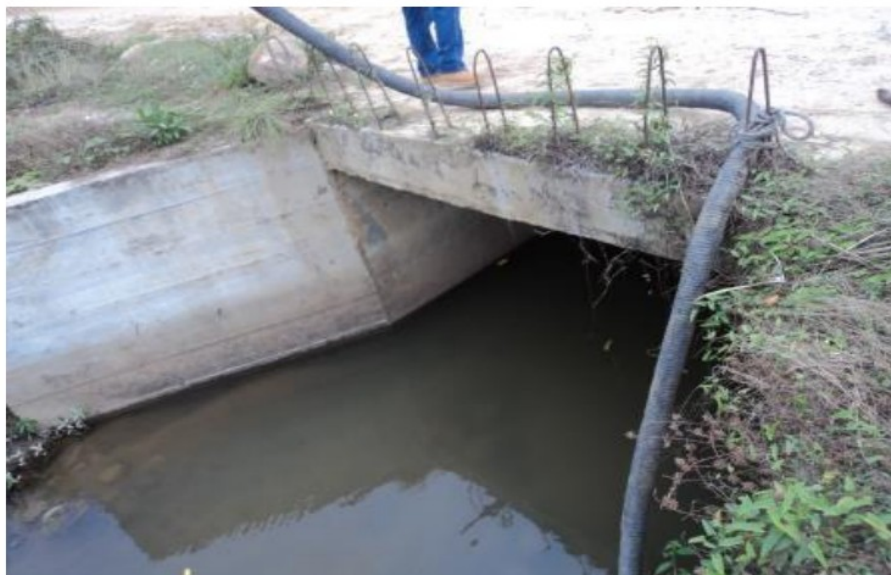
Fotografía 15. Punto de captación con carro tanque para irrigación de vía y control de polvo
