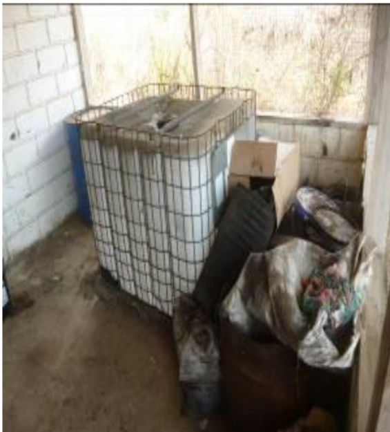
Fotografías 9, 10, 11, 12. Área destinada al almacenamiento de residuos o desechos peligrosos, vestigios de derrames de hidrocarburo, techos partidos que permiten el ingreso de humedad. 8 de abril de 2016.
