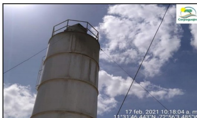
Figura 4. Mancha de cemento en la parte superior de uno de los silos. Fuente: CORPOGUAJIRA, 2021.
