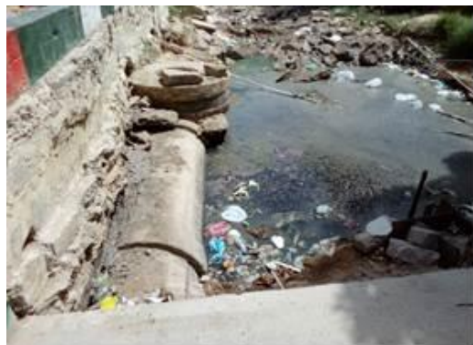
Fotos 1 y 2: Manjol # 1 vertimiento al suelo el cual tiene como destino final el humedal Boca Grande – Distrito de Riohacha
