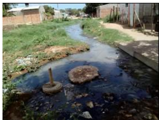
Fotos 5 y 6: Manjol # 3 vertimiento al suelo el cual tiene como destino final el humedal Boca Grande – Distrito de Riohacha
