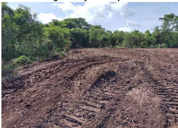
Fotografías 5 y 6. Descapote de área aledaña al sitio propuesto para la intervención
