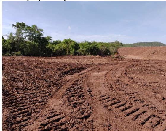
Fotografías 5 y 6. Descapote de área aledaña al sitio propuesto para la intervención
