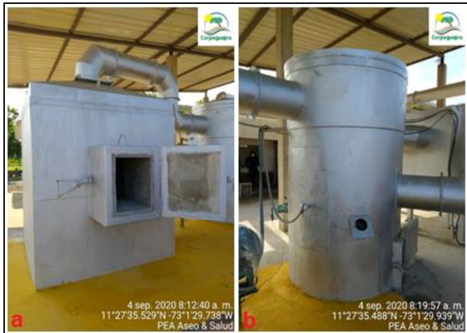
Figura 3. a. Cámara de combustión y b. Cámara de poscombustión del horno.
