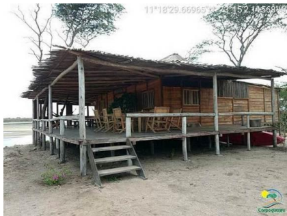
Cabaña principal ubicada sobre la boca de la laguna Mamavita, bases reforzadas en concreto sobre el sustrato arenoso.
