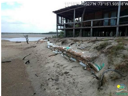
Adecuación artesanal del talud con bultos de arena para contener la erosión costera.
