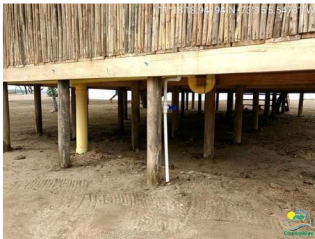
Detalle del sistema hidráulico de las cabañas (baños y duchas) y de las bases reforzadas en concreto y otras con piedras.
