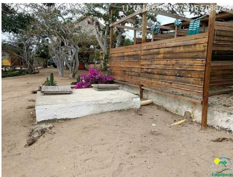
Poza séptica y tubería para la recolección de las aguas residuales.
