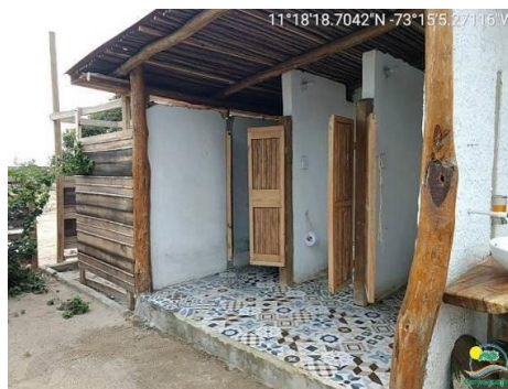
Sanitarios y duchas, piso en concreto, puertas y paredes en diferentes tipos de madera
