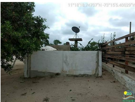
Tanque de almacenamiento de agua, al lado se encuentra una estructura con la electrobomba y otros materiales.
