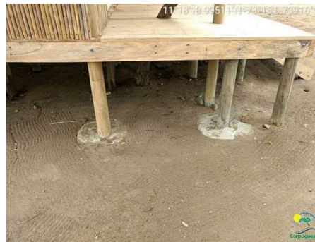
Detalle del sistema hidráulico de las cabañas (baños y duchas) y de las bases reforzadas en concreto y otras con piedras.
