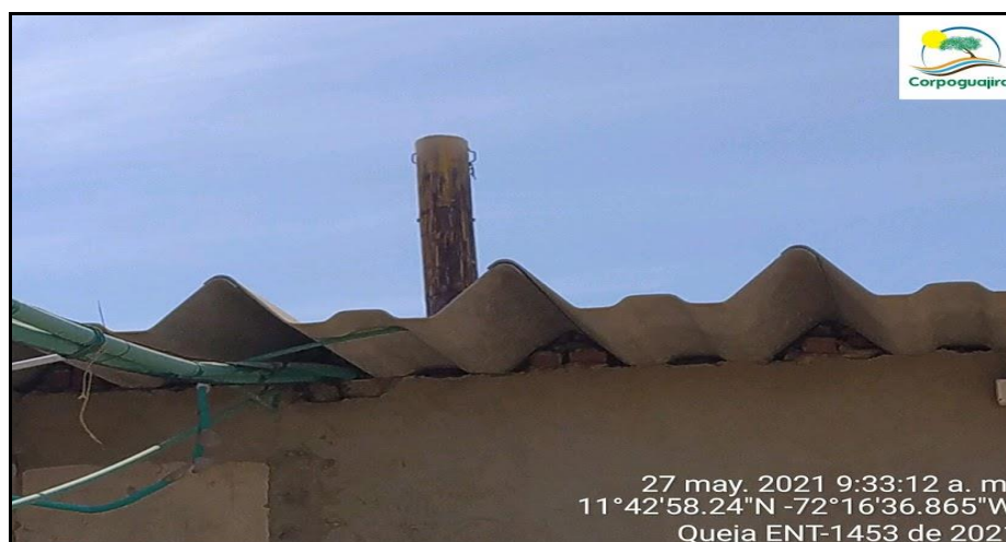
Figura 7. Chimenea de la empresa. Fuente: CORPOGUAJIRA, 2021.
