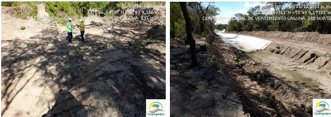
Fotografías No. 5 y 6. Canal de conducción del vertimiento Laguna 831 Norte sin revestimiento. CARBONES DEL CERREJON LIMITED – CERREJON. COMPLEJO MINA. 30 de noviembre del 2021. (Fuente: CORPOGUAJIRA).
