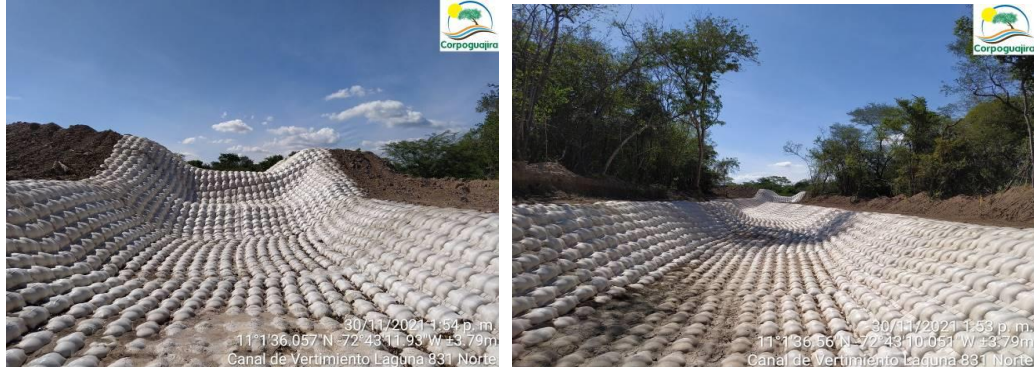
Fotografías No. 3 y 4. Canal de conducción del vertimiento Laguna 831 Norte con revestimiento. CARBONES DEL CERREJON LIMITED – CERREJON. COMPLEJO MINA. 30 de noviembre del 2021. (Fuente: CORPOGUAJIRA).
