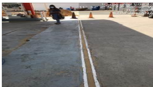
Fotografías 4 y 5: Canal perimetral. EDS JOHANA S.A.S, Riohacha, EDS JOHANA S.A.S, 10 de diciembre de 2021. (Fuente CORPOGUAJIRA)
