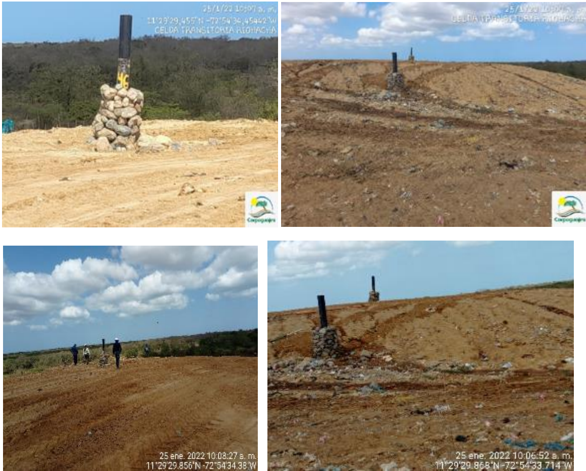
Fotos No 49 - 52. Chimeneas de gases en todas las celdas del SDF: Celda Transitoria, 25 de febrero de 2022 (Fuente. Corpoguajira)
