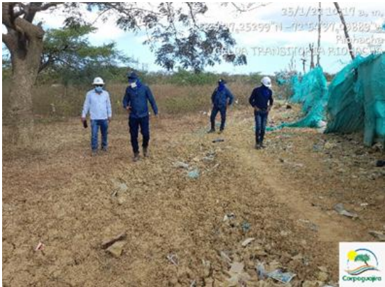
Fotos No 16. Área de inundación de aguas de escorrentías provenientes del SDF de Riohacha en el borde de la vía o carretable que separa el proyecto con las comunidades indígenas. Obsérvese la no ejecución de obras de drenaje. 25 de enero 2022 (Fuente. Corpoguajira)
