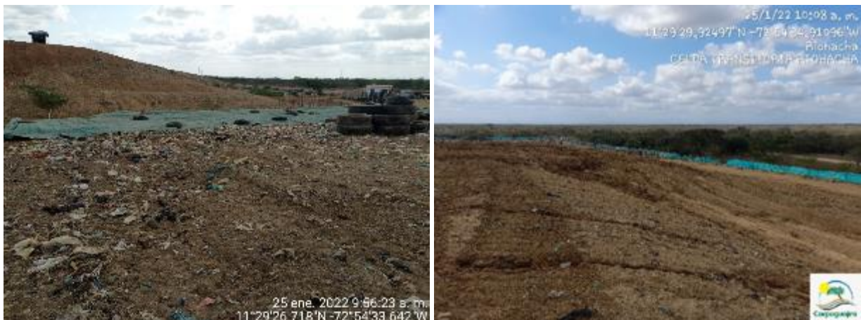
Fotos No 24-25. Cubrimiento de celdas en forma temporal y permanente. Celda Transitoria, 25 de enero de 2022 (Fuente. Corpoguajira)
