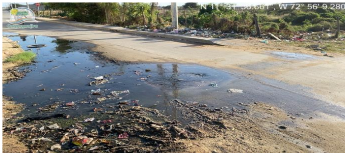
Foto 7. Tapa de registro de alcantarillado desbordada.
