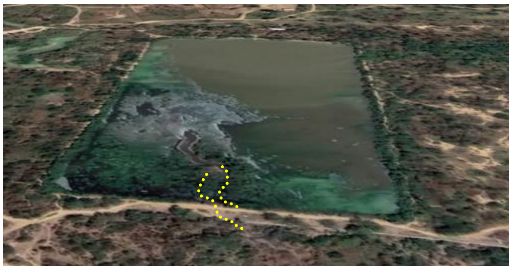
IMAGEN No 2. Ubicación espacial del sistema de tratamiento "Limoncito" de aguas residuales del municipio de Maicao, canal para encausar las aguas vertidas desde la tubería. Google Earth.
