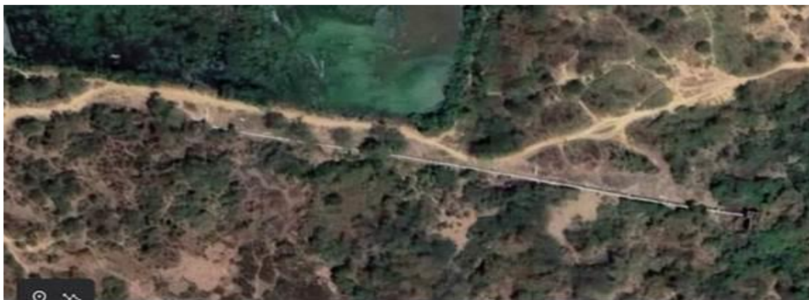
IMAGEN No 3. Tramo de tubería de entrada a la laguna de tratamiento sin presentar rupturas.
