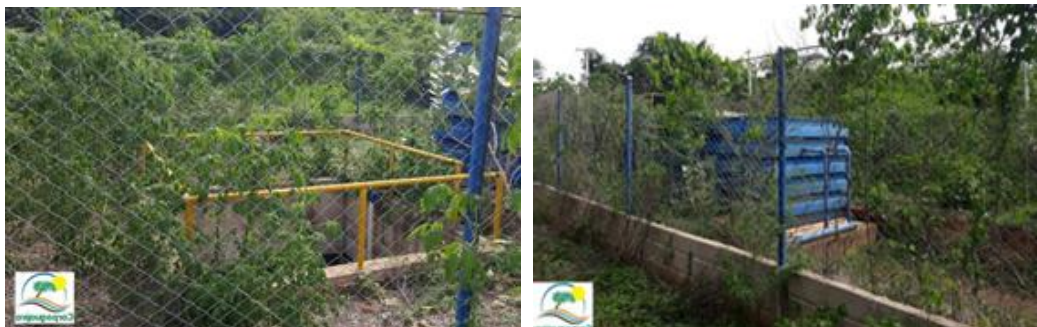
Fotografías No 1 - 2. Sistema de tratamiento de aguas residuales del corregimiento de Los Remedios, municipio de Albania. .
