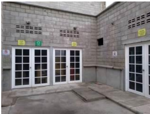
Fotografías 1: Caseta de almacenamiento temporal de residuos ordinarios. Parque Eólico Jepírachi. (Fuente: EPM. Correo electrónico de fecha 03 de mayo 2021).
