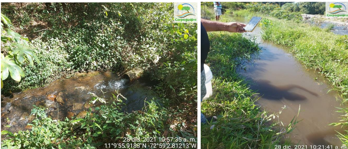
Fotos 1 y 2. Punto de vertimiento de la PTAP – ASAA S.A E.S.P.
