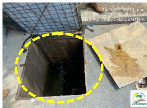
Fotografía No.13-14: Trampa de grasa, presencia de aguas aceitosas ESTACION DE SERVICIO AUTOMOTRIZ CENTRAL. 15 de octubre de 2021.
