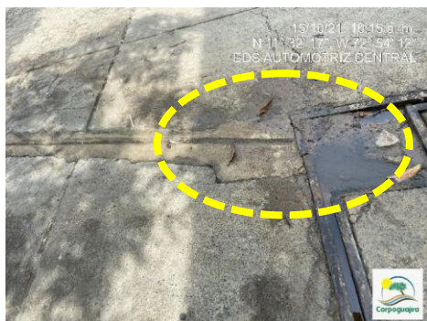
Fotografías No.11-12: canal perimetral de derrames. EDS AUTOMOTRIZ CENTRAL. 15 de octubre de 2021. (Fuente CORPOGUAJIRA)
