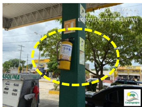
Fotografía No.15-16: Extintores ubicados en los surtidores de venta de combustible ESTACION DE SERVICIO AUTOMOTRIZ CENTRAL. 15 de octubre de 2021.
