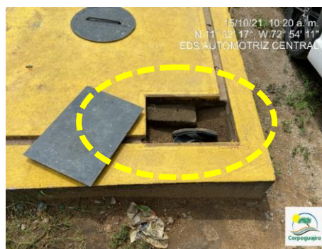
Fotografías No.11-12: canal perimetral de derrames. EDS AUTOMOTRIZ CENTRAL. 15 de octubre de 2021. (Fuente CORPOGUAJIRA)
