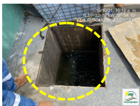
Fotografía No.13-14: Trampa de grasa, presencia de aguas aceitosas ESTACION DE SERVICIO AUTOMOTRIZ CENTRAL. 15 de octubre de 2021.
