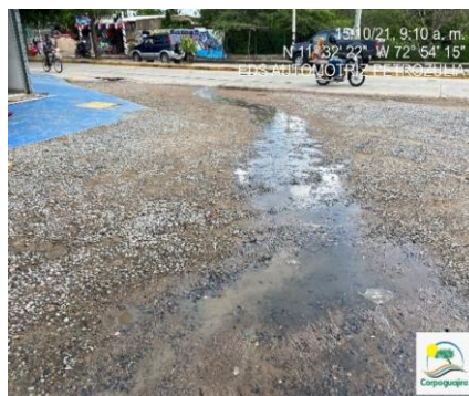
Fotografías N°.17 y N° 18: Cajilla recolectora del canal perimetral de surtidores. Derrame de aguas no domesticas desbordadas de la cajilla recolectora. EDS PETROZULIA.15 de octubre de 2021. (Fuente CORPOGUAJIRA)
