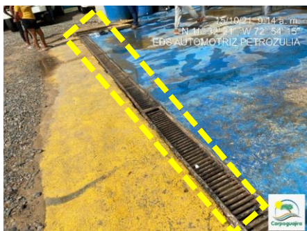
Fotografías N° 23 y N° 24. Canal de conducción y trampa de grasa, lavadero 2. EDS PETROZULIA .15 de octubre de 2021. (Fuente CORPOGUAJIRA)
