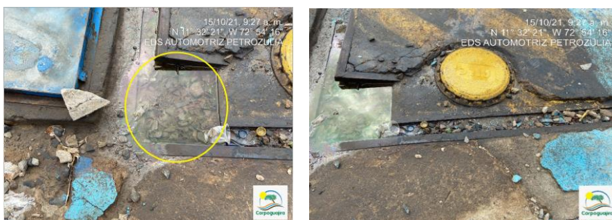
Fotografías N°. 15 y N° 16: Canal perimetral de los tanques de almacenamiento de combustible, se encuentra en mal estado sin el adecuado mantenimiento. 15 de octubre de 2021. (Fuente CORPOGUAJIRA)
