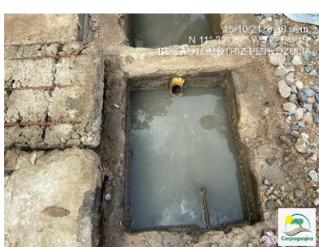
Fotografías N° 21 y N°22: Canal de conducción y trampa de grasa, lavadero 1. EDS PETROZULIA .15 de octubre de 2021. (Fuente CORPOGUAJIRA)
