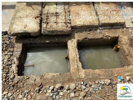
Fotografías N° 21 y N°22: Canal de conducción y trampa de grasa, lavadero 1. EDS PETROZULIA .15 de octubre de 2021. (Fuente CORPOGUAJIRA)
