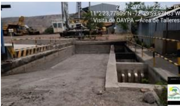
Fotografías No. 52 y 53. Lavadero de Equipos Mineros y Sistema de Tratamiento para Aguas Residuales Industriales. CARBONES COLOMBIANOS DEL CERREJÓN S.A.S. (Fuente: CORPOGUAJIRA, junio 2021).
