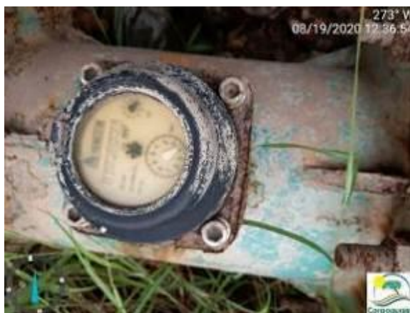
Fotografías No. 54. Vista del medidor de caudal al final de la red de conducción de los sumideros de Tajo. Que fue removido y en proceso de reubicación. CARBONES COLOMBIANOS DEL CERREJÓN S.A.S. (Fuente: CORPOGUAJIRA, agosto 2020).
