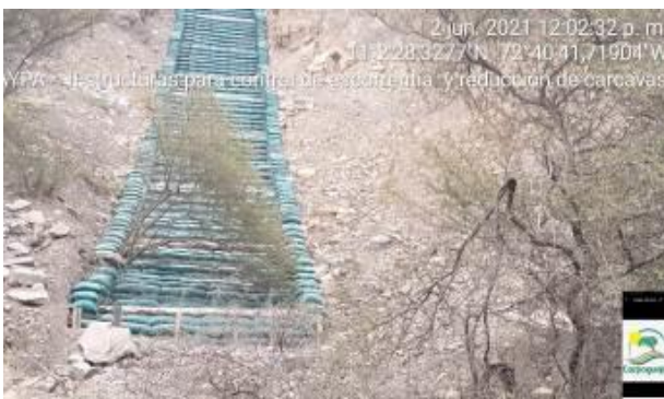
Fotografía No. 46 y 47: Evidencias de los trabajos realizados para mejorar el proceso de erosión en Cárcavas en el Antiguo Botadero de la Zona Norte. CARBONES COLOMBIANOS DEL CERREJÓN S.A.S. (Fuente: CORPOGUAJIRA, junio 2021).
