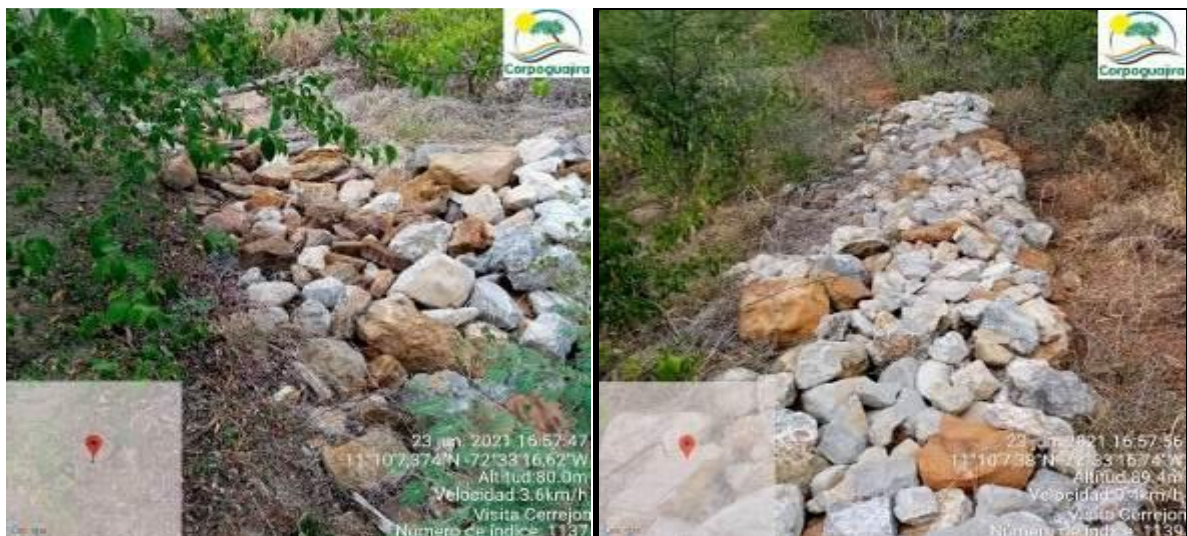
Fotografías No. 29 y 30. Obras de control de erosión en el nuevo cauce del arroyo -. CARBONES DEL CERREJON LIMITED – CERREJON. (Fuente: CORPOGUAJIRA 2021)
