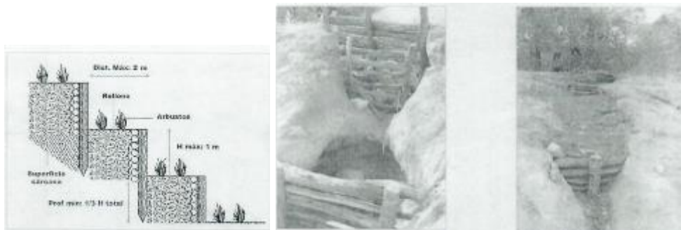
Fotografías No.19 a 21. Trinchos instalados en las cárcavas y proceso de instalación de trinchos – Arroyo Bruno (Fuente: Cerrejón 2020)
