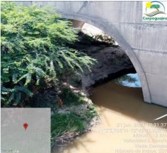
Fotografías No. 53 y 54. Procesos de Sedimentación en el Ala Izquierda del Puente Doña Raque (Río Ranchería). N. (Fuente. CORPOGUAJIRA 2021).
