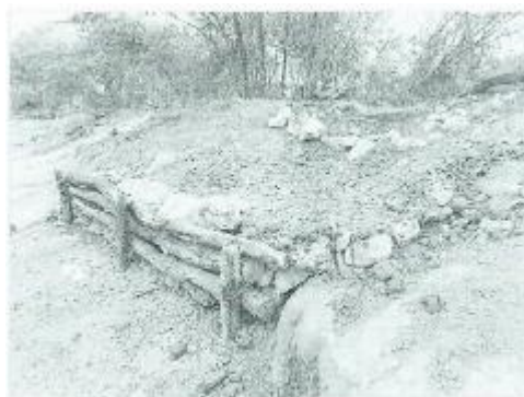
Fotografía No.22. Combinación de estrategias de conservación de suelo para estabilizar procesos erosivos– Arroyo Bruno (Fuente: Cerrejón 2020)
