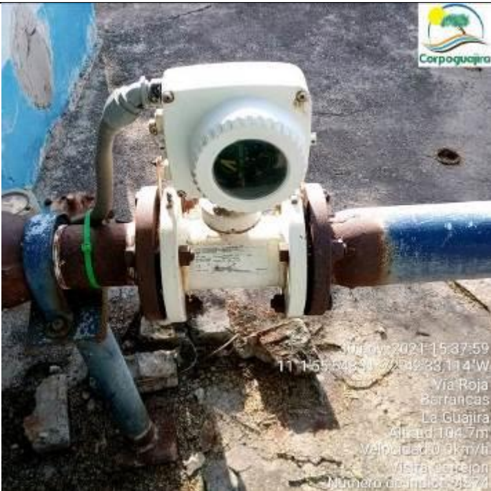
Fotografía No. 12. Medidor de Caudal dañado -Captación Carbocol. CARBONES DEL CERREJON LIMITED – CERREJON. (Fuente: CORPOGUAJIRA Nov 2021).
