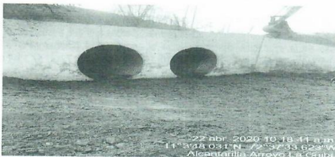
Fotografías No.17 y 18. Estructuras de puente y alcantarillado río ranchería y arroyo la Ceiba en buen estado de limpieza (Fuente: Cerrejón 2020)
