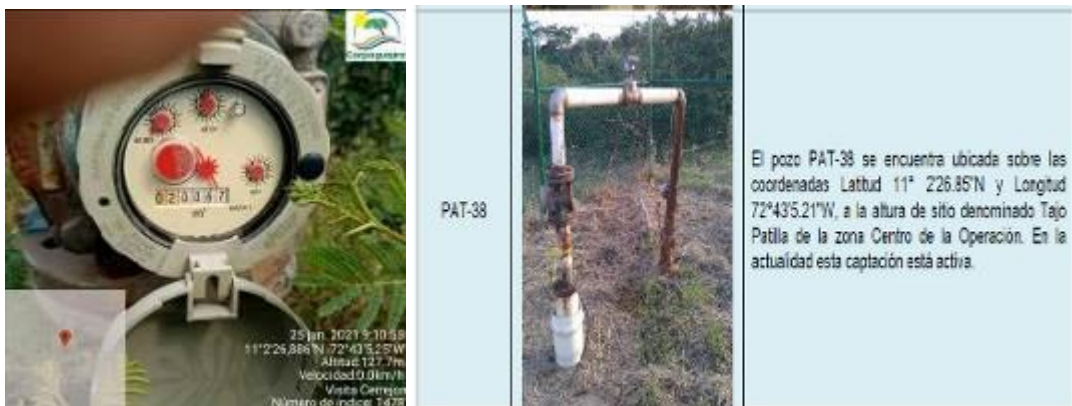
Fotografías No. 36 y 37. Medidor y ubicación Pozo de despresurización PAT -38 (Fuente: CORPOGUAJIRA 2021- Cerrejón 2020)
