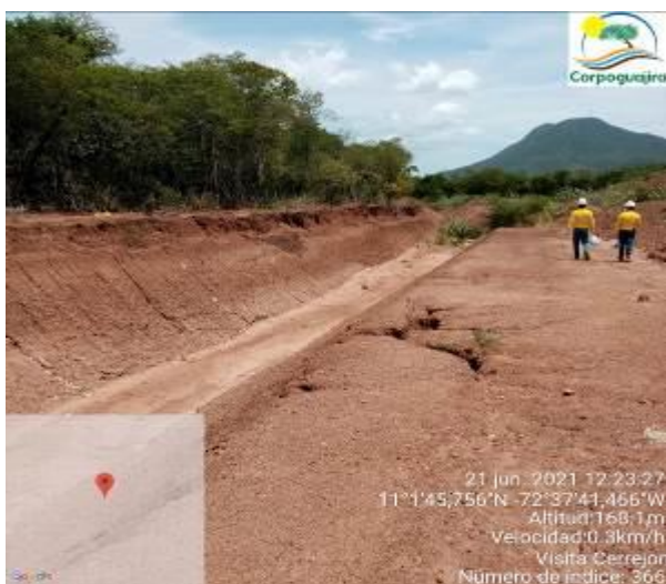
Fotografías No. 72 y 73. Canal que conecta al arroyo Cequión con el arroyo Los Estados (presencia de surcos y pequeñas cárcavas en los taludes). CARBONES DEL CERREJON LIMITED – CERREJON. (Fuente: CORPOGUAJIRA 2021)
