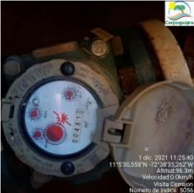
Fotografía No. 13. Medidor de Caudal en Pozo Profundo No. 9. CARBONES DEL CERREJON LIMITED – CERREJON.. (Fuente: CORPOGUAJIRA Dic 2021)
