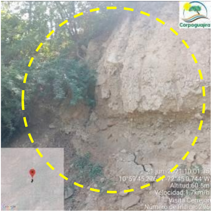
Fotografía No.50. Sector erosionado en el borde izquierdo de la vía Cerrejon – papayal a la altura del Puente Casa e Tabla. (Fuente. CORPOGUAJIRA 2021).
