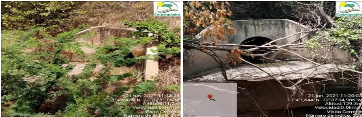
Fotografías No.55 y 56. Alcantarilla con obstrucción en la salida Arroyo La Ceiba (Fuente. CORPOGUAJIRA 2021).
