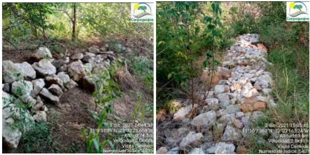
Fotografías No. 28 ay 29. Obras de control de erosión en el nuevo cauce del arroyo -. CARBONES DEL CERREJON LIMITED – CERREJON. (Fuente: CORPOGUAJIRA Dic 2021)
