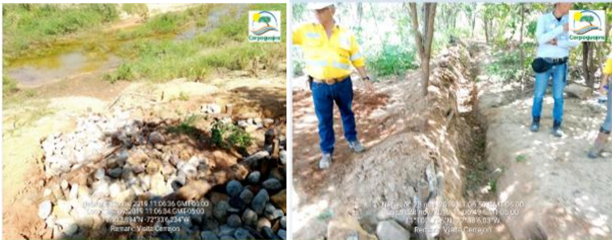
Fotografía No.23 y 24. Canales de control de derivas y protección de taludes para estabilizar procesos erosivos– Arroyo Bruno (Fuente: Corpoguajira nov de 2019)
