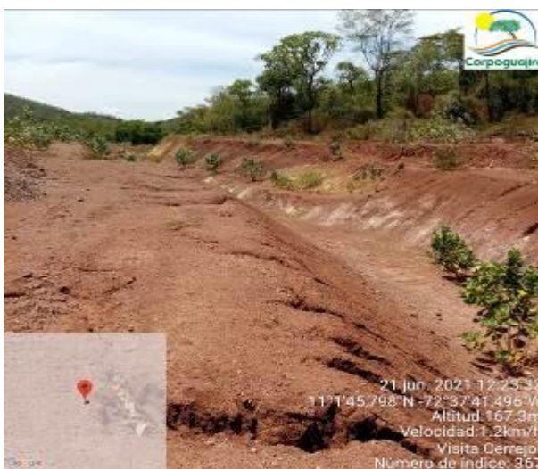
Fotografías No. 72 y 73. Canal que conecta al arroyo Cequión con el arroyo Los Estados (presencia de surcos y pequeñas cárcavas en los taludes). CARBONES DEL CERREJON LIMITED – CERREJON. (Fuente: CORPOGUAJIRA 2021)
