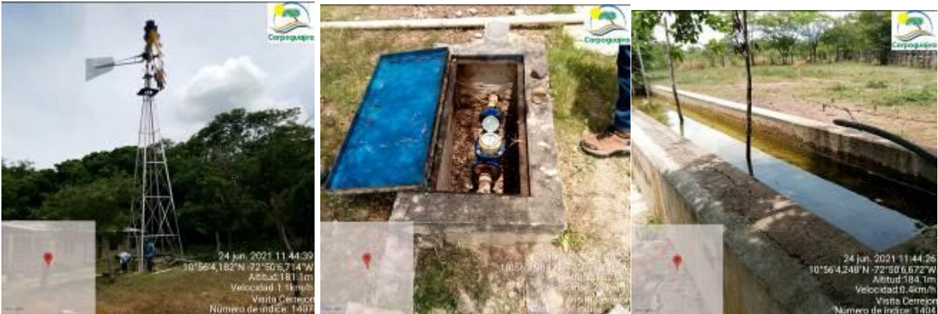
Fotografías No. 42 y 43. Pozo Artesano, sistema de medición y Usos del Agua. (Fuente: CORPOGUAJIRA 2021).
