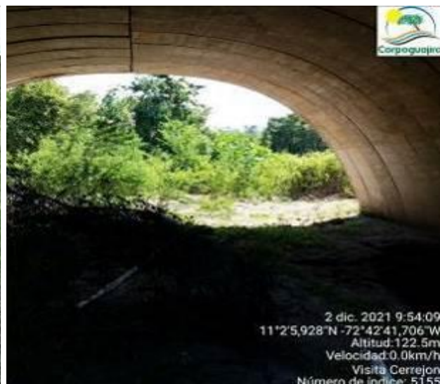
Fotografías No. 79 a 80. Procesos de Sedimentación en el Ala Izquierda del Puente Doña Raque (Rio Ranchería). N. (Fuente: CORPOGUAJIRA 2021).
