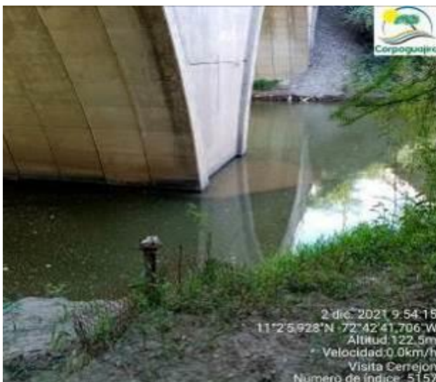
Fotografías No. 79 a 80. Procesos de Sedimentación en el Ala Izquierda del Puente Doña Raque (Rio Ranchería). N. (Fuente: CORPOGUAJIRA 2021).
