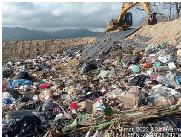
Foto 16. Disposición de residuos por fuera de la isla de disposición definida al interior de la celda activa. Relleno sanitario de Dibulla. Fecha: 3 de marzo de 2022. Fuente: CORPOGUAJIRA
