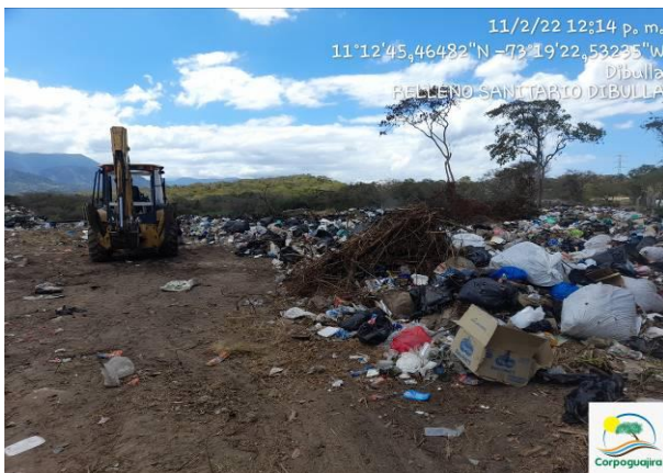
Fotos 17 y 18. Maquinaria desplazando los residuos ubicados fuera de la Celda en Relleno Sanitario de Dibulla al interior de ésta. Fecha: 11 de febrero de 2022. Fuente: CORPOGUAJIRA
