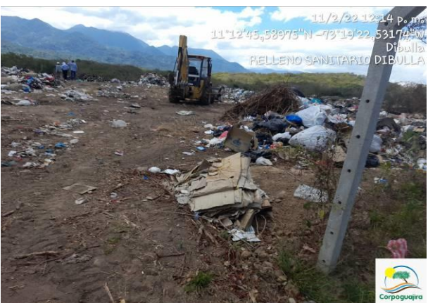
Fotos 17 y 18. Maquinaria desplazando los residuos ubicados fuera de la Celda en Relleno Sanitario de Dibulla al interior de ésta. Fecha: 11 de febrero de 2022. Fuente: CORPOGUAJIRA
