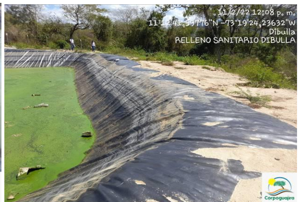
Fotos 23 y 24. Sistema de tratamiento de lixiviados en el Relleno Sanitario de Dibulla. Fecha: 11 de febrero de 2022. Fuente: CORPOGUAJIRA
