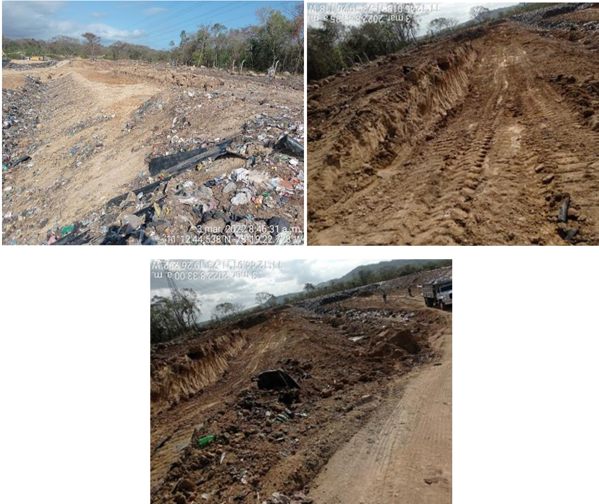
Foto 17, 18 y 19. Actividades de ampliación de celda activa. Relleno sanitario de Dibulla. Fecha: 3 de marzo de 2022. Fuente: CORPOGUAJIRA
