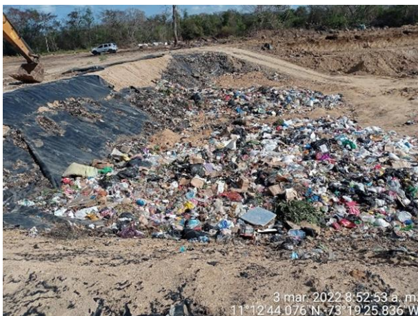
Fotos 6 y 7. Residuos dispuestos en la parte baja de la celda por fuera de la isla central programada. Relleno sanitario de Dibulla. Fecha: 3 de marzo de 2022. Fuente: CORPOGUAJIRA
