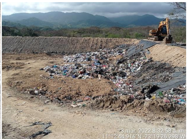
Fotos 6 y 7. Residuos dispuestos en la parte baja de la celda por fuera de la isla central programada. Relleno sanitario de Dibulla. Fecha: 3 de marzo de 2022. Fuente: CORPOGUAJIRA
