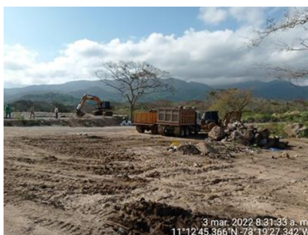
Foto 20, 21, 22, 23 y 24. Actividades de desmonte, limpieza para ampliación de celda, construcción de vías y obras de arte. Relleno sanitario de Dibulla. Fecha: 3 de marzo de 2022. Fuente: CORPOGUAJIRA
