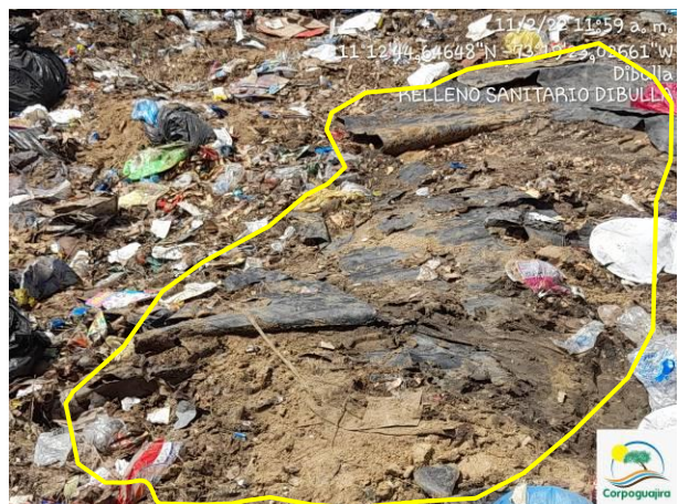
Fotos 19 y 20. Geomembrana deteriorada en el punto donde arrojaban los residuos. Fecha: 11 de febrero de 2022. Fuente: CORPOGUAJIRA
