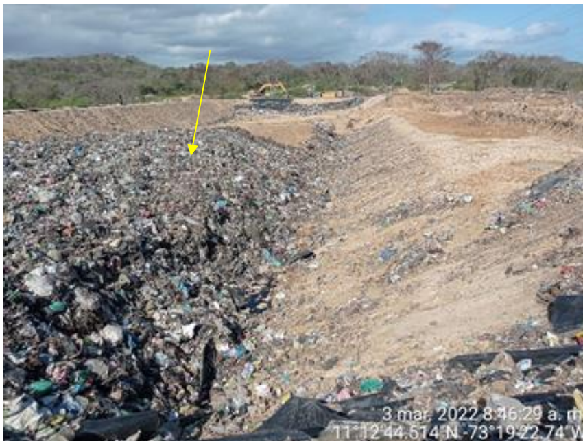
Foto 5. Isla central dentro de la celda para la disposición de residuos. Relleno sanitario de Dibulla. Fecha: 3 de marzo de 2022. Fuente: CORPOGUAJIRA
