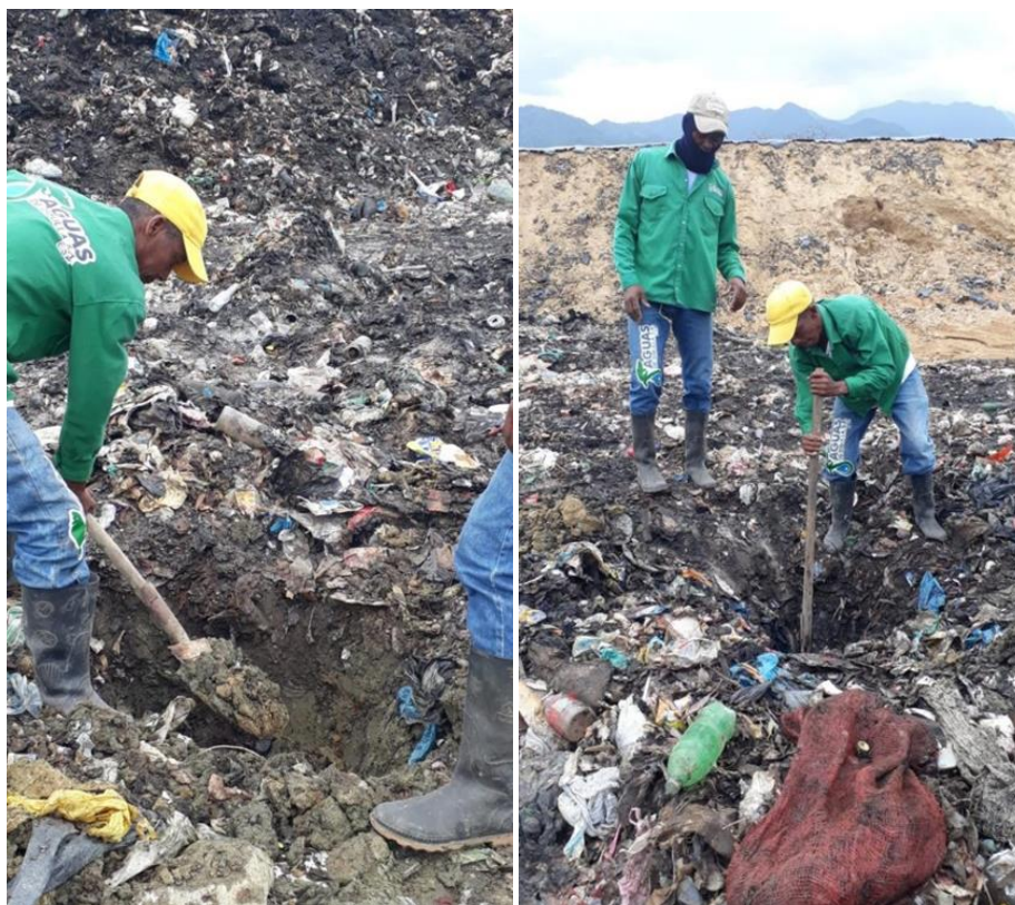
Foto 2 y 3. Calicatas en la celda del relleno sanitario de Dibulla. Fecha: 14 de febrero 2022. Fuente: Alcaldía de Dibulla
