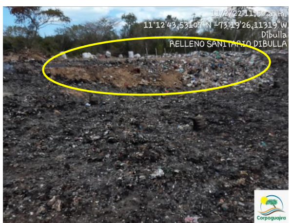
Fotos 1, 2, 3 y 4. Residuos sólidos en la Celda en Relleno Sanitario de Dibulla incinerados y geomembrana destruida. Fecha: 11 de febrero de 2022. Fuente: CORPOGUAJIRA
