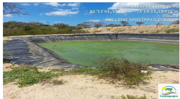
Fotos 21 y 22. Sistema de tratamiento de lixiviados en el Relleno Sanitario de Dibulla. Fecha: 11 de febrero de 2022. Fuente: CORPOGUAJIRA
