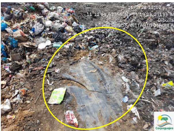
Fotos 19 y 20. Geomembrana deteriorada en el punto donde arrojaban los residuos. Fecha: 11 de febrero de 2022. Fuente: CORPOGUAJIRA
