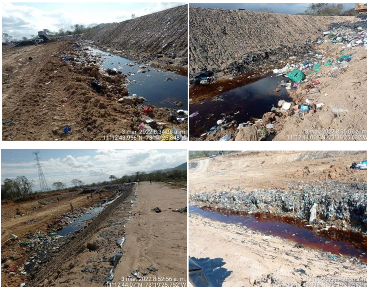
Fotos 12 - 15. Lixiviados acumulados en la base de los taludes norte y sur en áreas donde la geomembrana se quemó. Relleno sanitario de Dibulla. Fecha: 3 de marzo de 2022. Fuente: CORPOGUAJIRA
