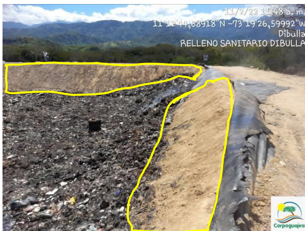
Fotos 1, 2, 3 y 4. Residuos sólidos en la Celda en Relleno Sanitario de Dibulla incinerados y geomembrana destruida. Fecha: 11 de febrero de 2022. Fuente: CORPOGUAJIRA
