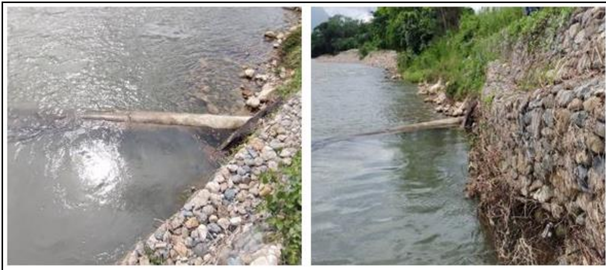
Figura 2. Estado actual de la de la tubería de gas Natural aflorando sobre el lecho del Río Cañas.
