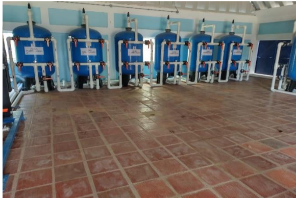
Fotografía 5. PTAP sistema Osmosis inversa instalada frente al sitio propuesto para el pozo
