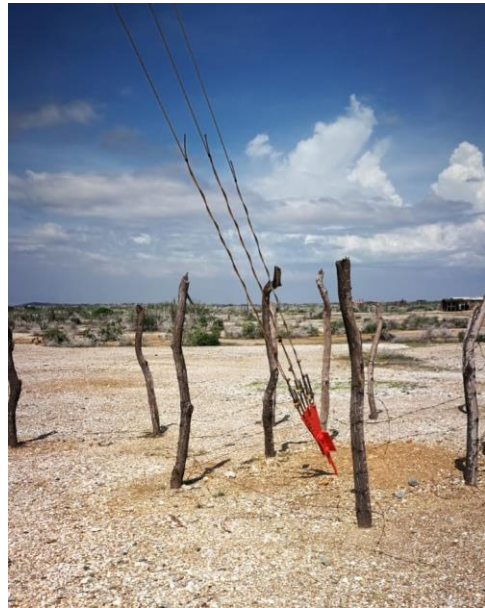
Foto 4. Aspecto físico de la estructura de torre. Fuente: CORPOGUAJIRA, 2021.
