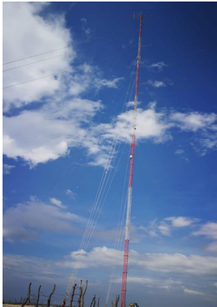
Foto 3. Desviadores de vuelo instalados. Fuente: CORPOGUAJIRA, 2021.
