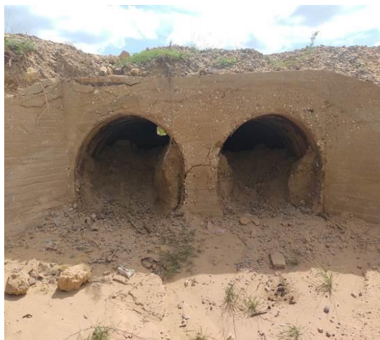
Fotografías 9 y 10 Arroyo con pequeño cauce aferente de la microcuenca de los arroyos Chemerrain-Kutamajana, propuesta para la ocupación de cauce No 7, presenta una obra hidráulica con alcantarilla de tubo metálico corrugado en el estado
