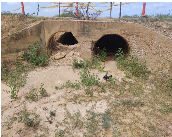
Fotografías 9 y 10 Arroyo con pequeño cauce aferente de la microcuenca de los arroyos Chemerrain-Kutamajana, propuesta para la ocupación de cauce No 7, presenta una obra hidráulica con alcantarilla de tubo metálico corrugado en el estado
