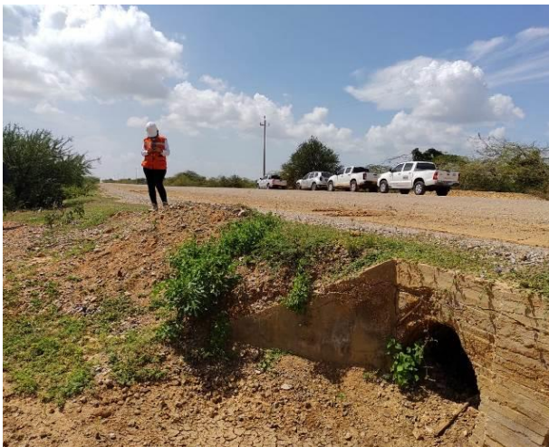
Fotografía 5. Cauce de escorrentías tributario de la microcuenca Chemerrain Kutanamana ocupación de cauce No 3, estructura deteriorada
