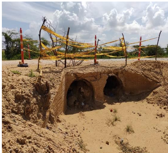
Fotografía.6. Cauce de escorrentías tributario de la microcuenca Chemerrain Kutanamana ocupación de cauce No 4, estructura en muy mal estado de intervención urgente
