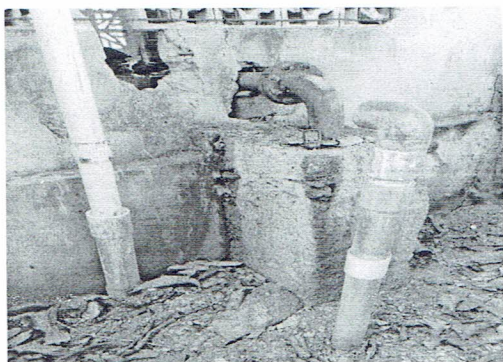
Fotografías 2 y 3. Pozo de producción de agua empujado en concreto
