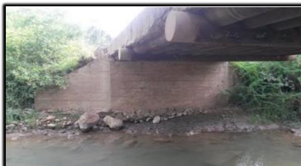
Imagen 6: Estribos y aletas – Cimentación.
