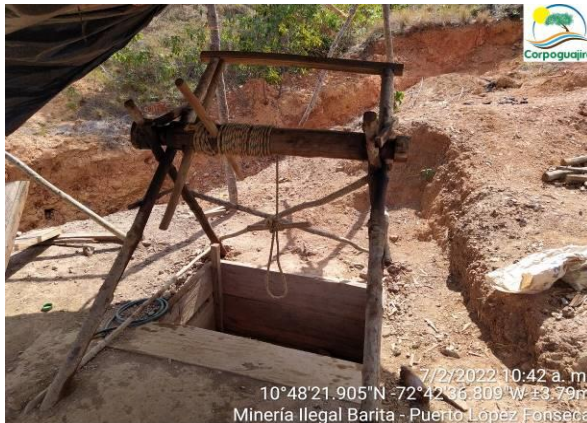
Fotografía No. 01 y 02. Creación de un túnel subterráneo para la explotación de mineral Barita. 07 de febrero de 2022. (Fuente: Corpoguajira 2022).
