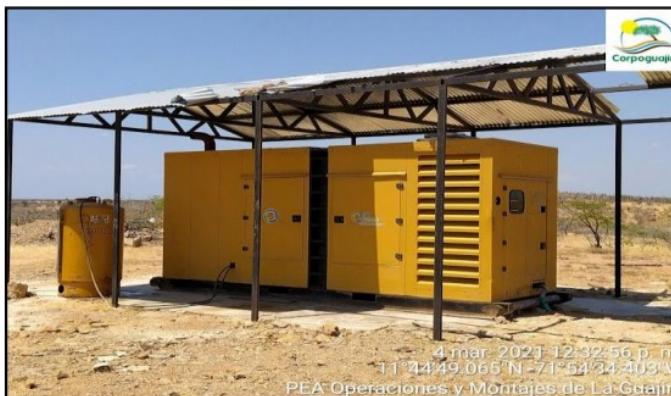
Figura 12. Área del generador eléctrico y tanque de almacenamiento de Diesel.
