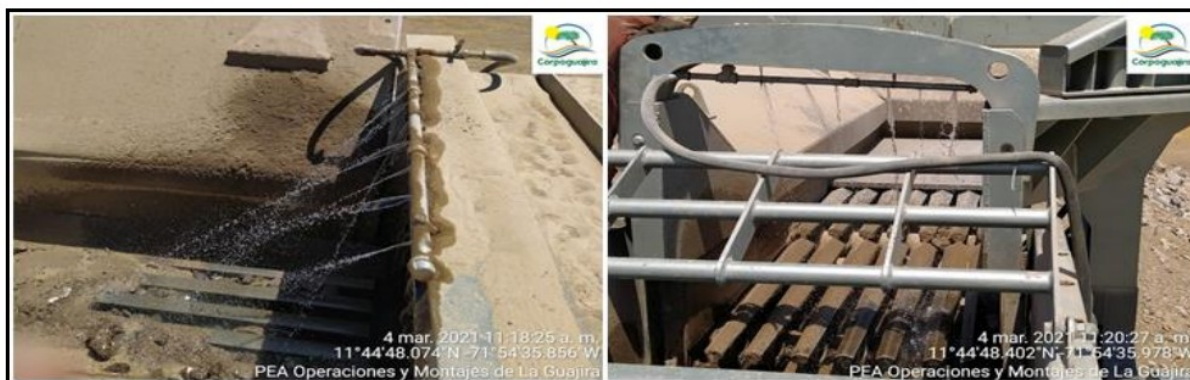
Figura 15. Sistema de flautas para el control de emisiones.
