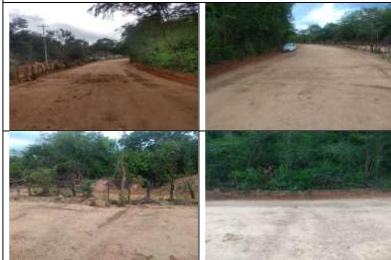
REFERENCIA: Alcantarilla No 3
