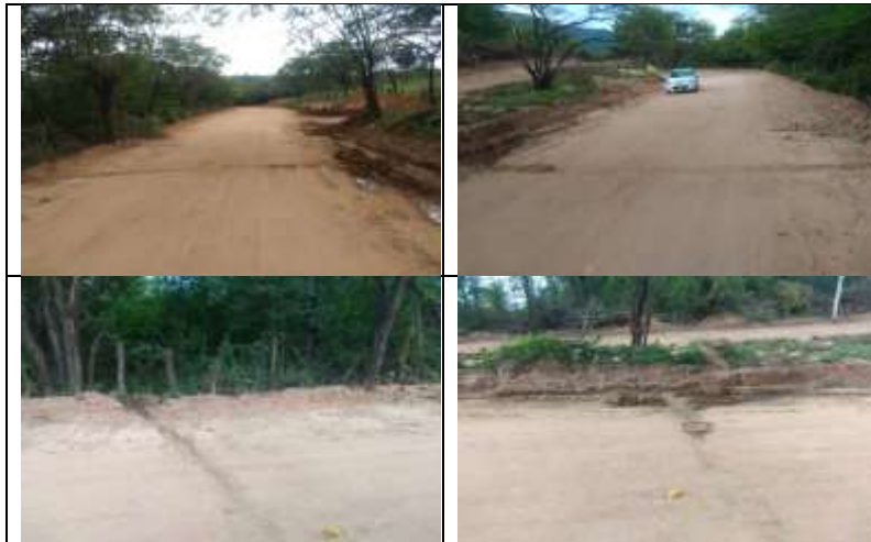
REFERENCIA: Alcantarilla No 2
