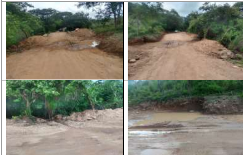
REFERENCIA: Alcantarilla No 4
