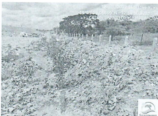
Foto 2 -7. 18 de julio de 2022 Celda Transitoria Riohacha. Canal de escorrentía y Jarillón limite oeste Celda Transitoria. Fuente Corpoguajira
