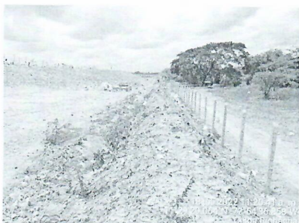
Foto 2 -7. 18 de julio de 2022 Celda Transitoria Riohacha. Canal de escorrentía y Jarillón limite oeste Celda Transitoria. Fuente Corpoguajira
