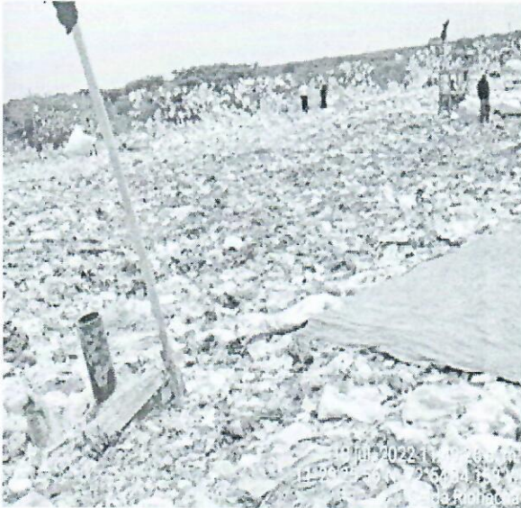
Foto 21 - 24. Fecha. 18 de julio de 2022. Cobertura de residuos con material terreo y lona verde en celda activas. Celda transitoria Riohacha. Fuente Corpoguajira
