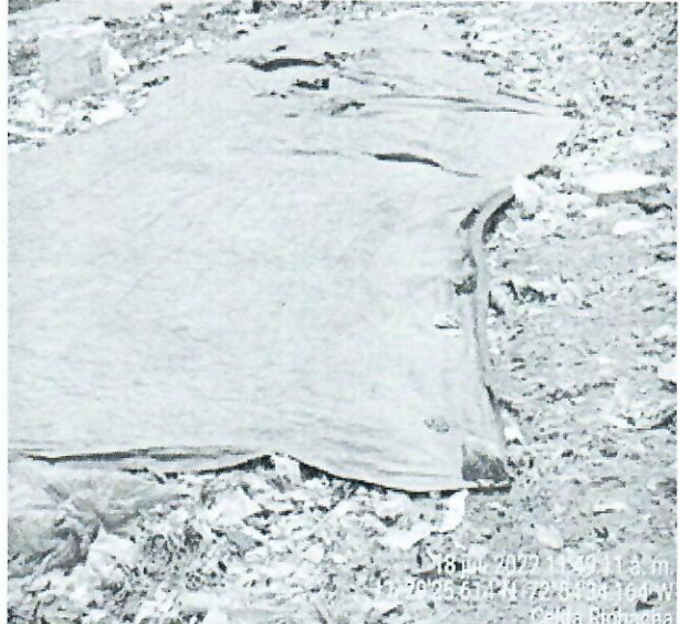
Foto 21 - 24. Fecha. 18 de julio de 2022. Cobertura de residuos con material terreo y lona verde en celda activas. Celda transitoria Riohacha. Fuente Corpoguajira
