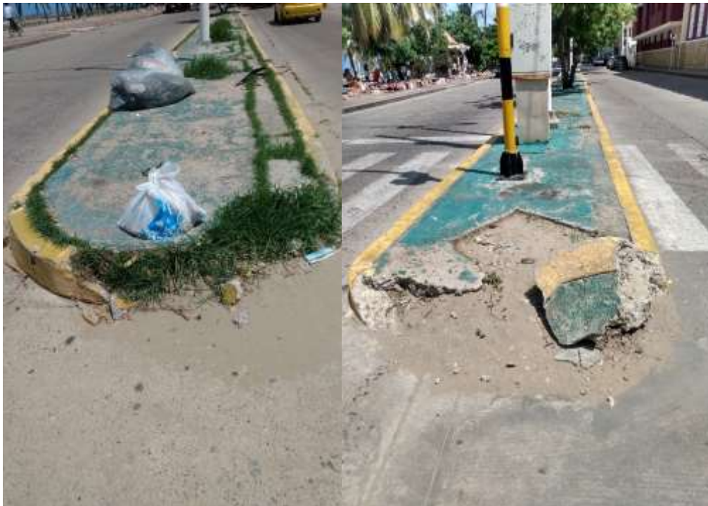
Figura 7. Bordillos de bulverad en malas condiciones Fuente: Elaboración Propia
