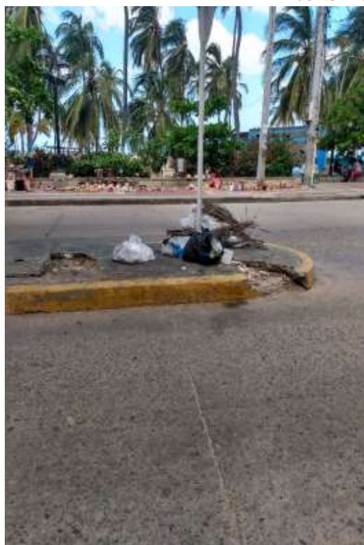
Figura 6. Avanzado deterioro de bordillos de boulevard Fuente: Elaboración Propia
