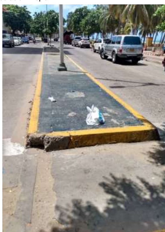
Figura 6. Avanzado deterioro de bordillos de boulevard Fuente: Elaboración Propia
