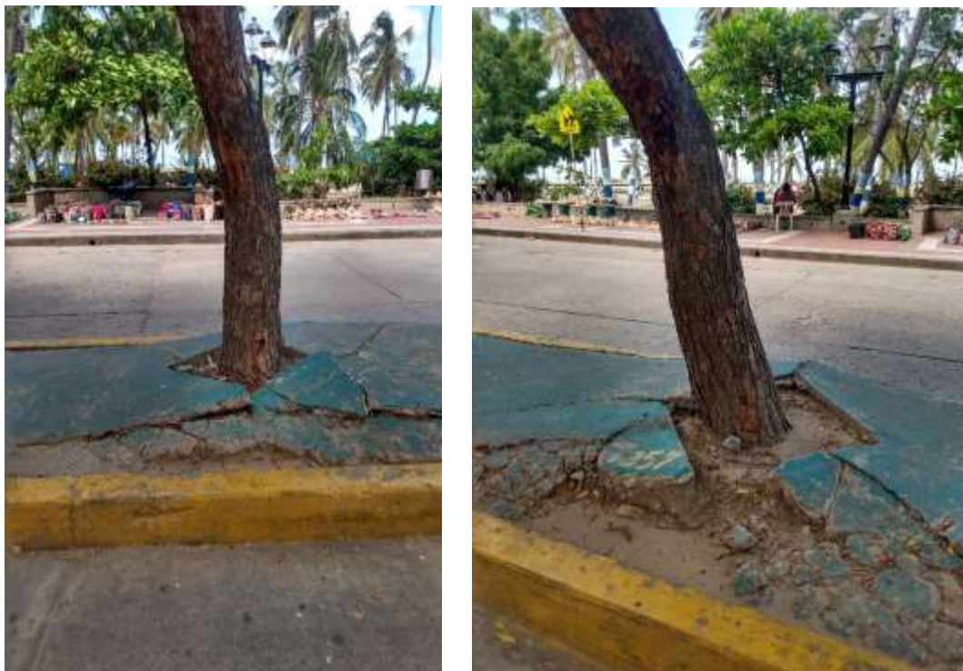
Figura 4. Deterioro de placa de boulevard Fuente: Elaboración propia
